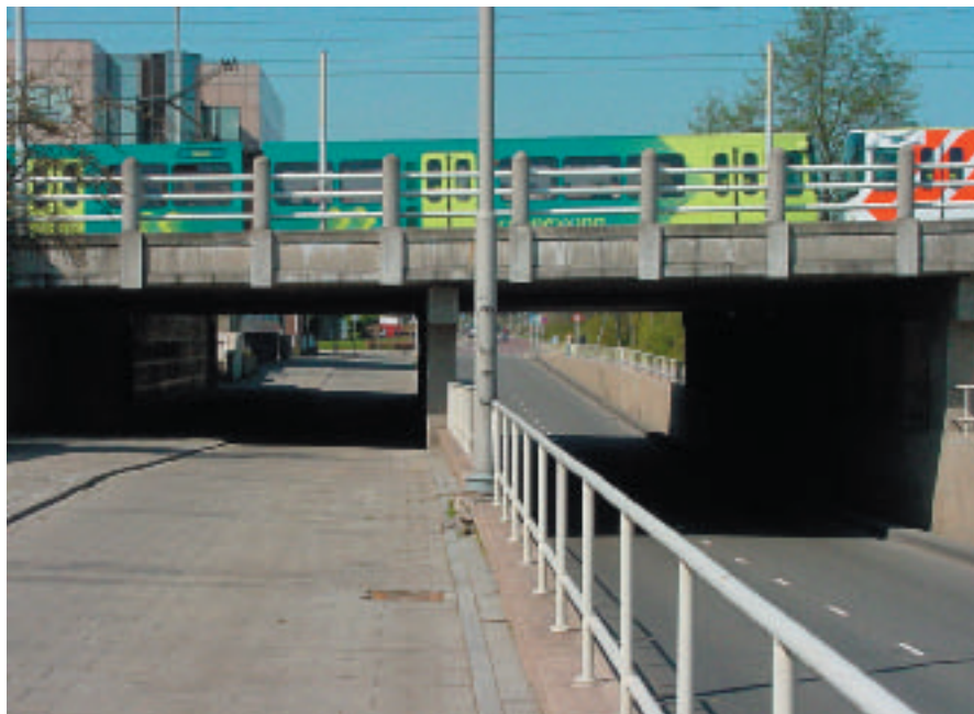
foto 20: r ditevig, infrastructure segregado para bicicletas
