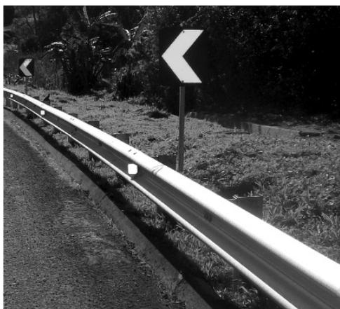
**Figura 4.5 – Exemplo de barreira de contenção metálica.**
