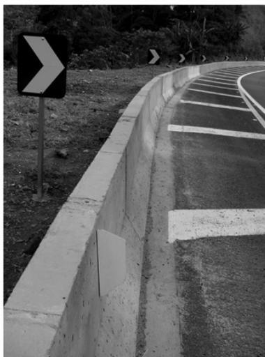
**Figura 4.4 – Exemplo de barreira de contenção de concreto.**
