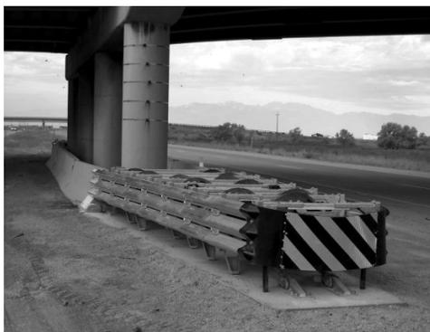
**Figura 4.7 – Exemplo de dispositivo amortecedor de impacto em pilar de viaduto. Fonte: Lindsay<sup>44</sup>.**
