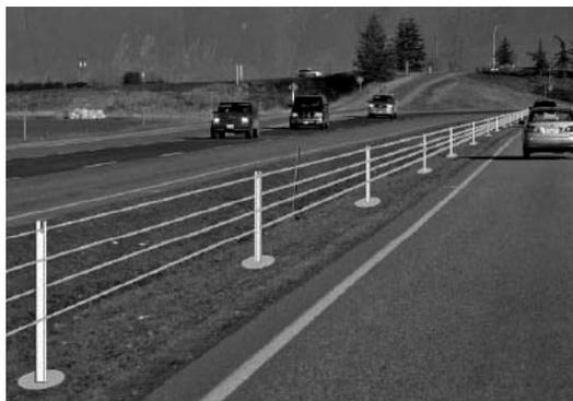
**Figura 4.6 – Exemplo de barreira de contenção com cabos de aço. Fonte: *Journal of Commerce*<sup>42</sup>.**
