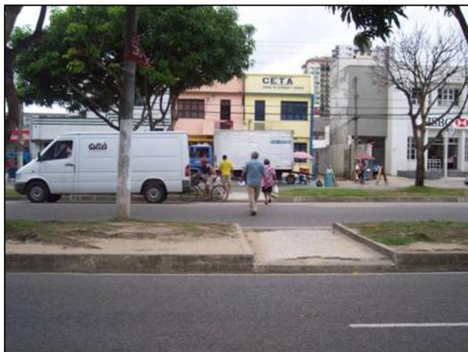
**Figura 7.8:** Rebaixamento do canteiro central na Av. P. Miranda.
