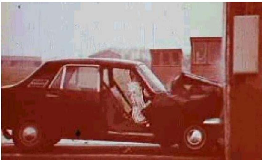
Figura 2-4 Instante em que o ocupante colide contra o painel em um crash test antigo – Disponível em:
