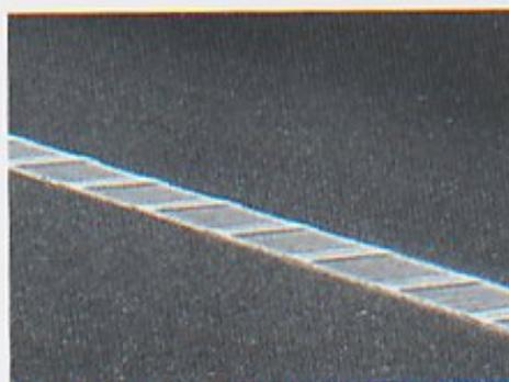
Figura 7 Detalhe do Megaline Profile aplicado na Nova Via Dutra - SP
