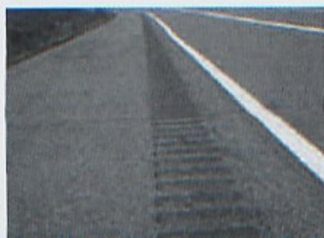
**Figura 4** Guias Sonoras conformadas no local (Fonte: [www.hf.faa.gov/.../n14a\\_Redundancy2.htm](http://www.hf.faa.gov/.../n14a_Redundancy2.htm))
